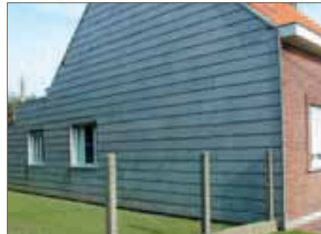
Gevelleien in asbestcement
